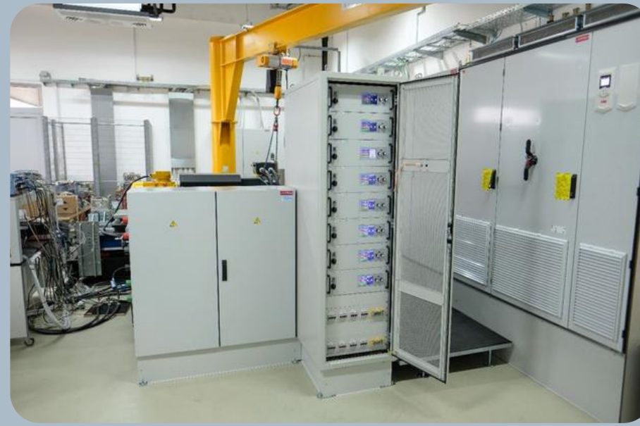
enosmerni napajalni sistem za simulacije razpršenih virov s sklopom opreme za upravljanje energetskih sistemov skupaj s hibridnim sončnim sistemom
